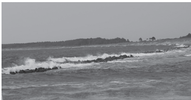
Fot. 1. Falochrony brzegowe rozbijające fale w rejonie Darłowa (Boniecka 2017)
